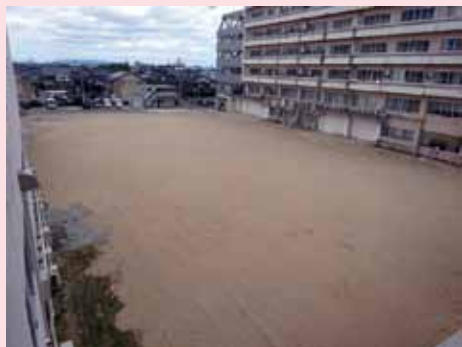
【平成 30 年 6 月旧リハ棟と 旧MR I 棟解体工事後】
