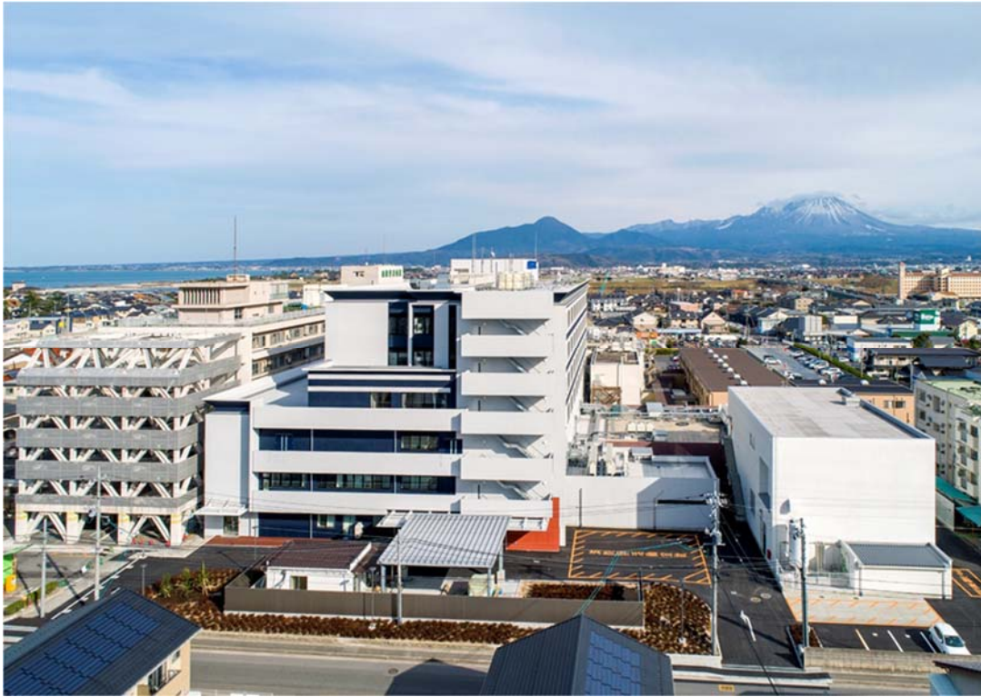
秀峰大山と新棟（中央）。西からの外観。
