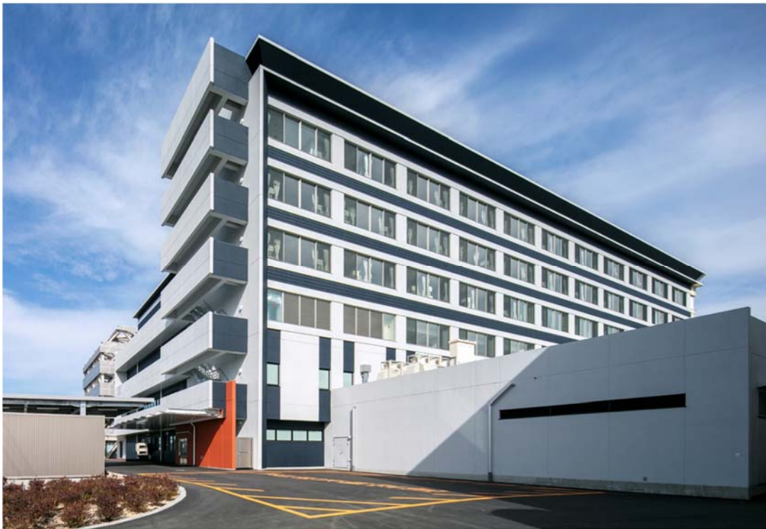
6階建ての新棟、救急センター（左茶色壁部分）と画像センター（右白色部分）
